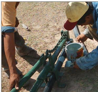
También se puede hacer esta unión por calor, luego de lijar las dos puntas de los caños a unir, se impregna con pegamento o pintura ambas puntas, se calienta con un soplete, para dilatar el caño de unión, y se introduce en la unión primero un caño y luego el otro.
